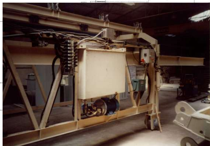
Grupo hidráulico encofrado túnel.
