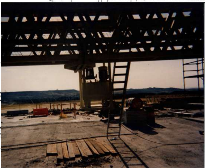
Grupo hidráulico para utillaje de encofrar.(Aeropuerto de Barajas T4)
